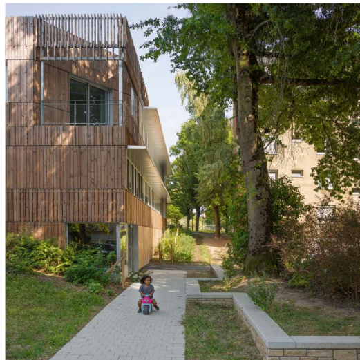
Crédit : Architecte DLW, Nantes
